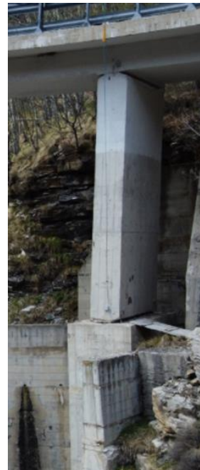
Pila lato Piaggia
