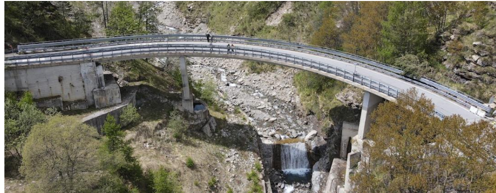
Prospetto lato valle
