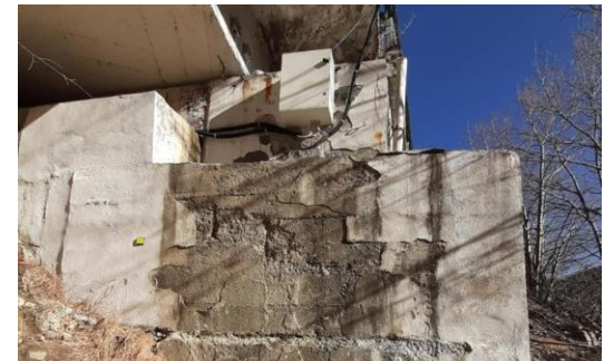
Spalla lato Piaggia
