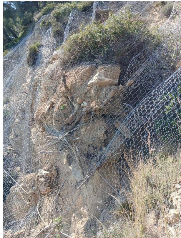
Figura 4 – sistema di consolidamento corticale a rete in evidente avanzato stato di degrado
