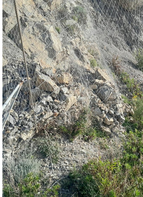
Figura 1 – Sistema di consolidamento corticale in avanzato stato di ammaloramento, causa formazione sacche e assenza di adeguato sistema di rinforzo con barre di ancoraggio e funi di rinforzo
