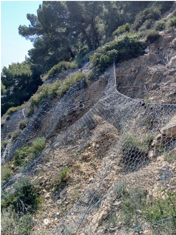
Figura 4 – sistema di consolidamento corticale a rete in evidente avanzato stato di degrado
