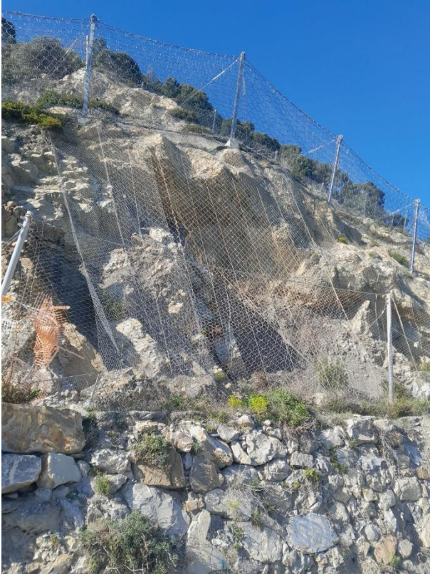
Figura 1 – Sistema di consolidamento corticale in avanzato stato di ammaloramento, causa formazione sacche e assenza di adeguato sistema di rinforzo con barre di ancoraggio e funi di rinforzo
