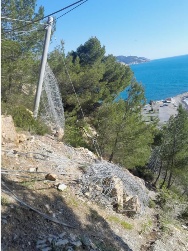
Figura 2: Immagini fotografiche della barriera paramassi BP.I.30, con evidenza delle criticità descritte nel testo
