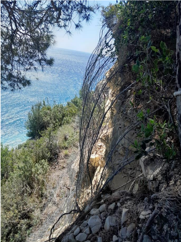
Figura 5: Immagini fotografiche dell'intervento di consolidamento corticale RC.DM.13, con evidenza delle criticità descritte nel testo
