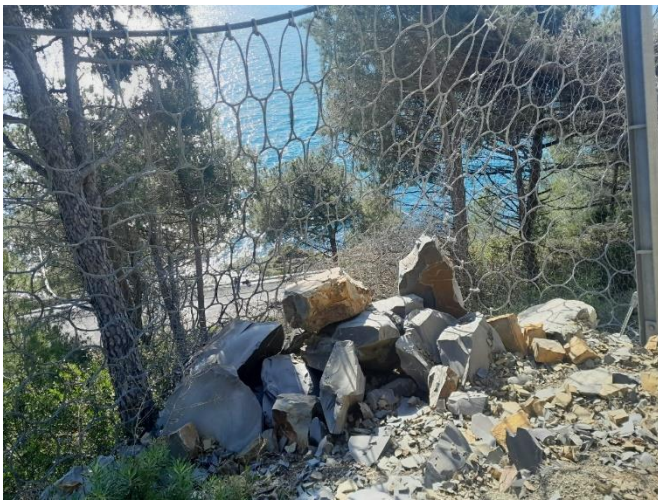
Figura 2: Immagini fotografiche della barriera paramassi BP.I.30, con evidenza delle criticità descritte nel testo
